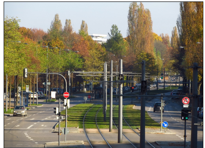
Abb. 3: Blick auf den Querschnitt der Englschalkinger Straße Richtung Osten. Die Trambahn verkehrt hier auf einem besonderen Bahnkörper in Straßenmittellage, die Busse verkehren auf den Fahrstreifen des MIV.
