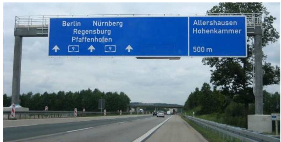
Abb. 3: Wechselwegweisung am Ende des ersten Bauabschnittes
