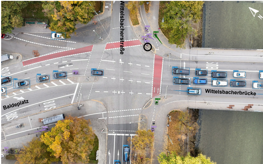
Abb. 1: Drohnenaufnahme: Knotenpunkt Wittelsbacherbrücke/Wittelsbacherstraße
