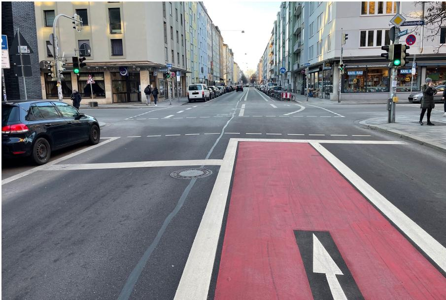
Abb. 1 Radfahrstreifen in Mittellage und indirektem Linksabbiegen für den Radverkehr
