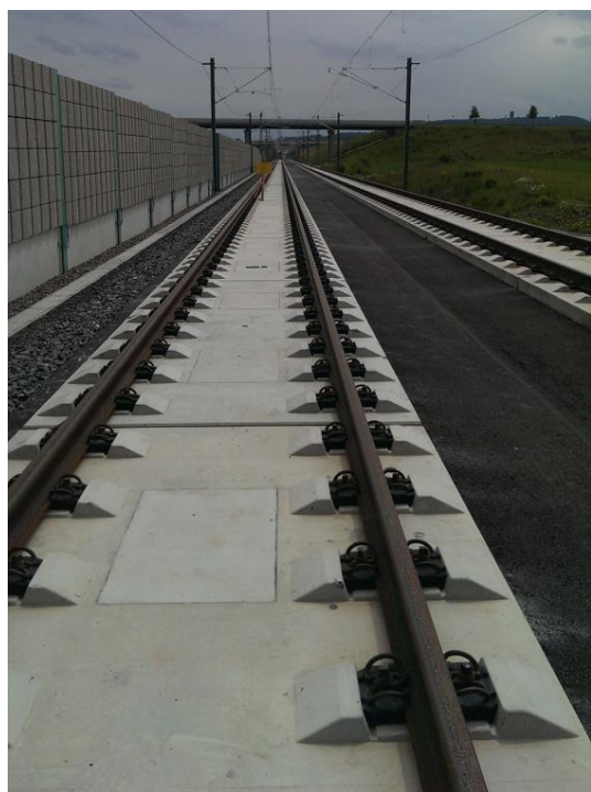
Fertiger Abschnitt der Neubaustrecke
