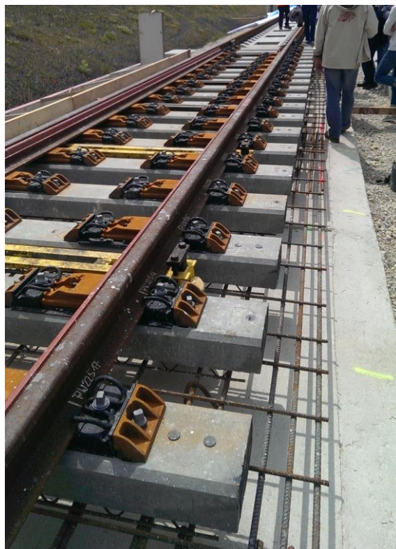
Aufbau des REHDA 2000 im Weichenbereich
