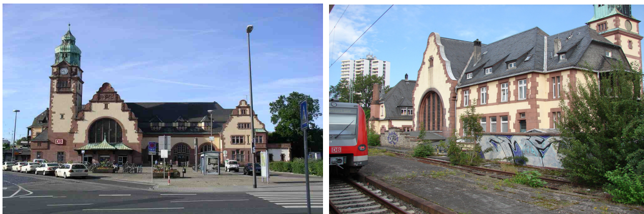
Abbildung 26: Derzeitiger Zustand des Empfangsgebäudes in Bad Homburg v.d.H. (links: Nordfassade am Bahnhofsvorplatz; rechts: Südseite an der Gleisseite)
